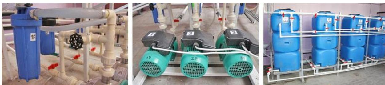
Слева: фильтрующий блок, по центру: насосы рециркуляции (гидравлический блок), справа: узел рециркуляции рабочих растворов
