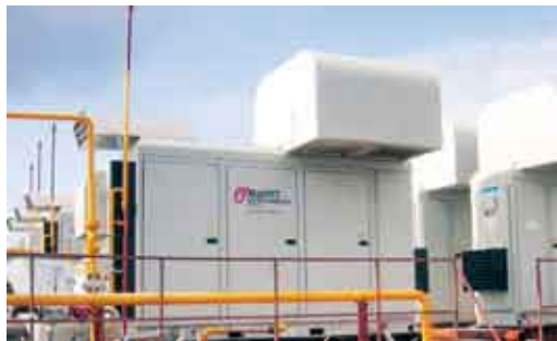
Рис. 2. Общий вид MTU для эксплуатации снаружи помещения до -40°C с воздухозаборником с пониженным уровнем шума
