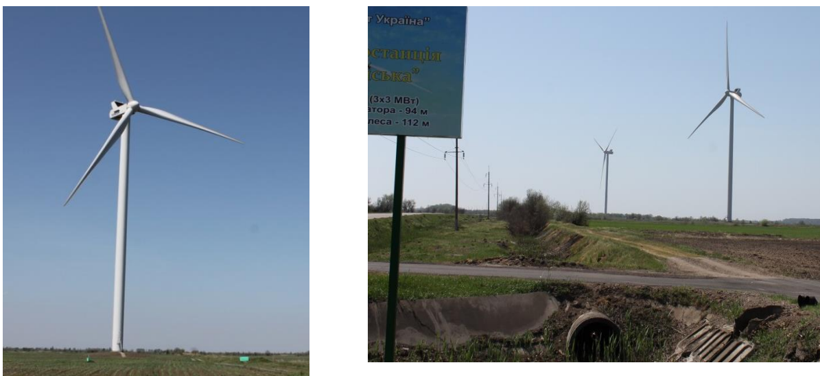
Рис. 11. Ветровая электростанция (Украина). Мощность 9МВт (3×3 МВт), высота до оси генератора 94 м, диаметр рабочего колеса 112 м
