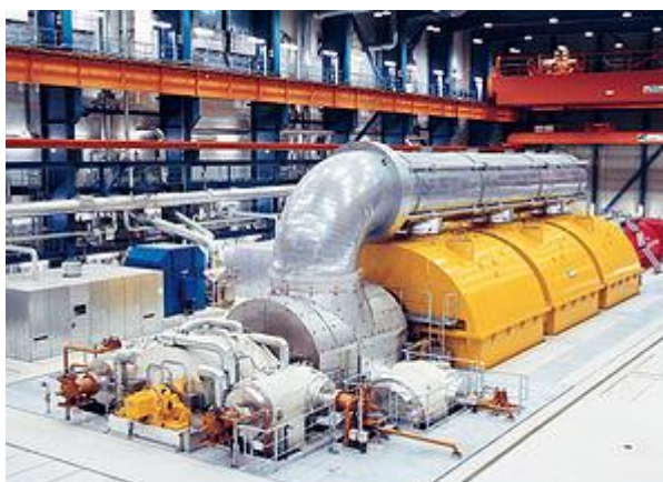
Рис. 1. Турбогенератор
