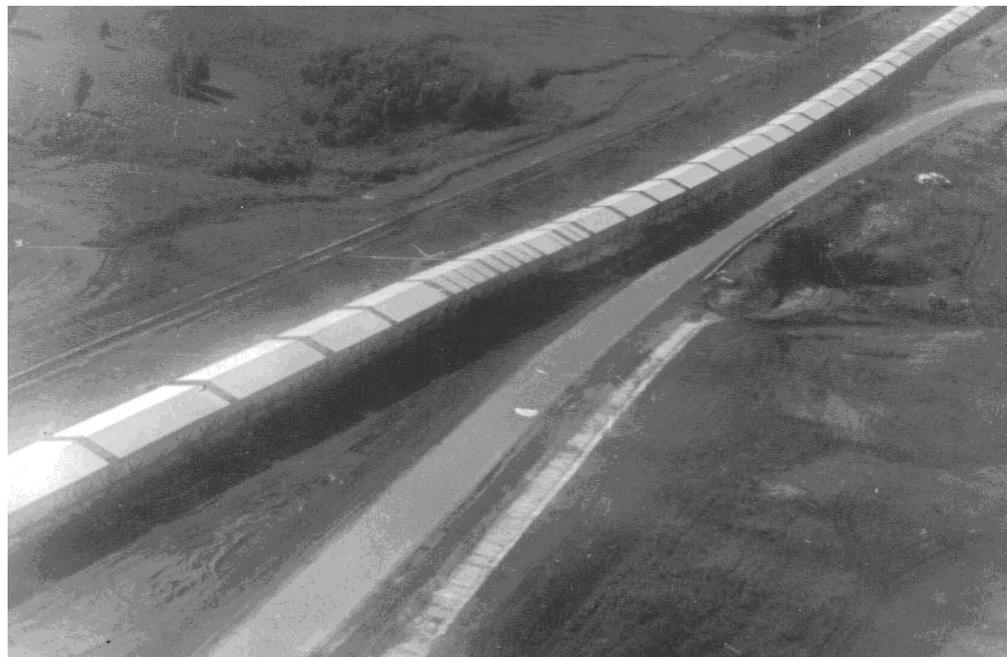
Березовская ГРЭС знаменита нетрадиционной схемой поставки топлива. Бурый уголь поступает на станцию непосредственно с Березовского месторождения Канско-Ачинского бассейна с разреза «Березовский-1» двумя 14-километровыми открытыми конвейерами. Проектная производительность разреза - 55 млн тонн угля в год. Всего за один час на ГРЭС может поступать до 4,5 тыс. тонн угля. За год на золоотвал станции поступает 250 - 300 тыс. тонн сухой золы. Удаление золы осуществляется системой гидрозолоудаления.
