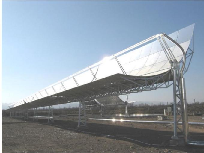
Рисунок 11 - Фокусирующий коллектор с парабоцилиндрическим концентратором
