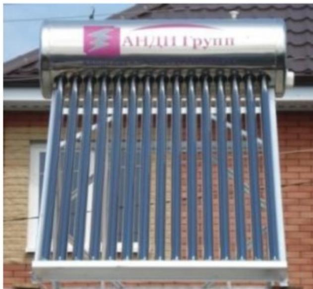
Рисунок 8 - Вакуумный коллектор с прямой теплопередачей воде и встроенным теплообменником
