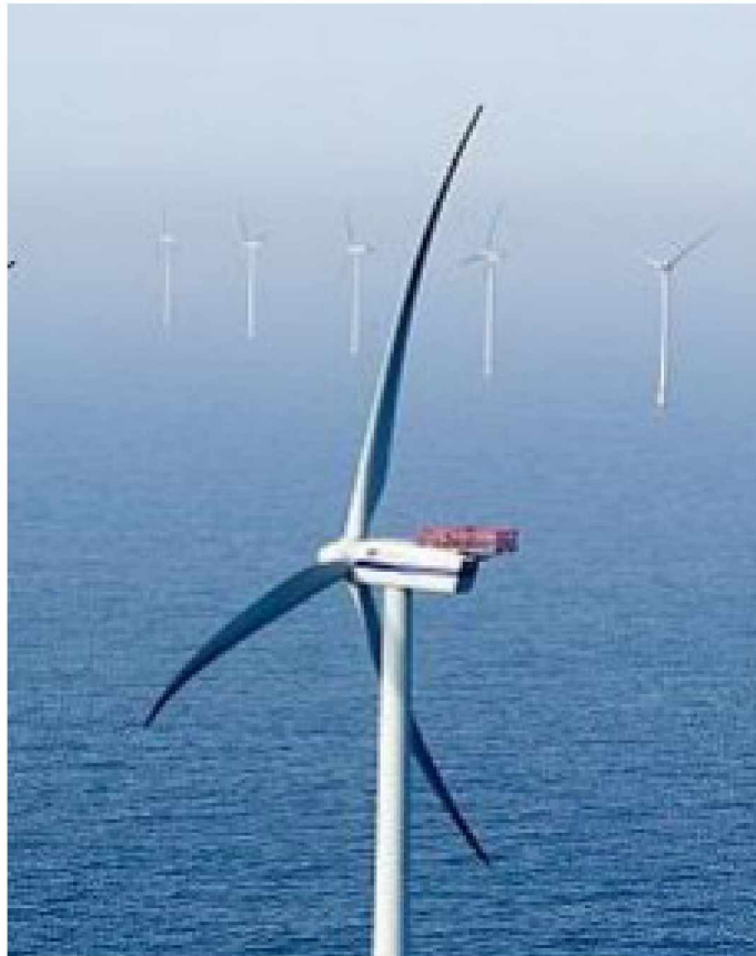
Рис. 4.10 Прогибы лопастей ВК ВЭУ
