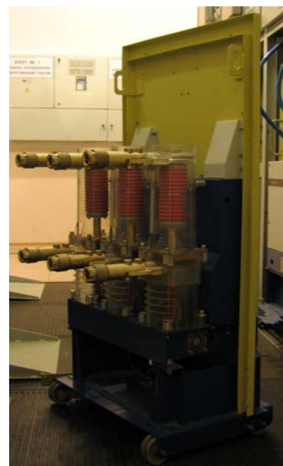
Рисунок 4. Вакуумный выключатель Саратовского завода «Контактор»
