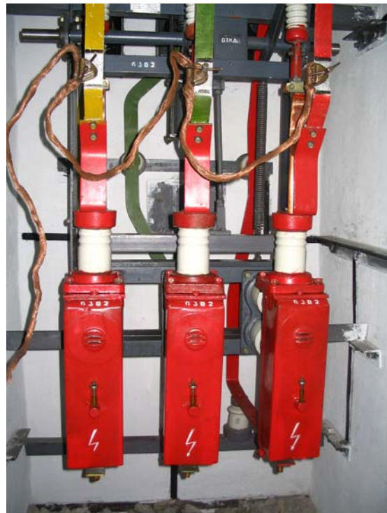
Рисунок 3. Выключатель ВМГ-133 стационарного исполнения (вид со стороны полюсов).
