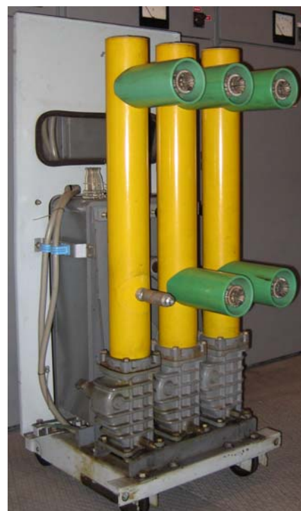
Рисунок 4. Масляный выключатель на выкатном элементе.
