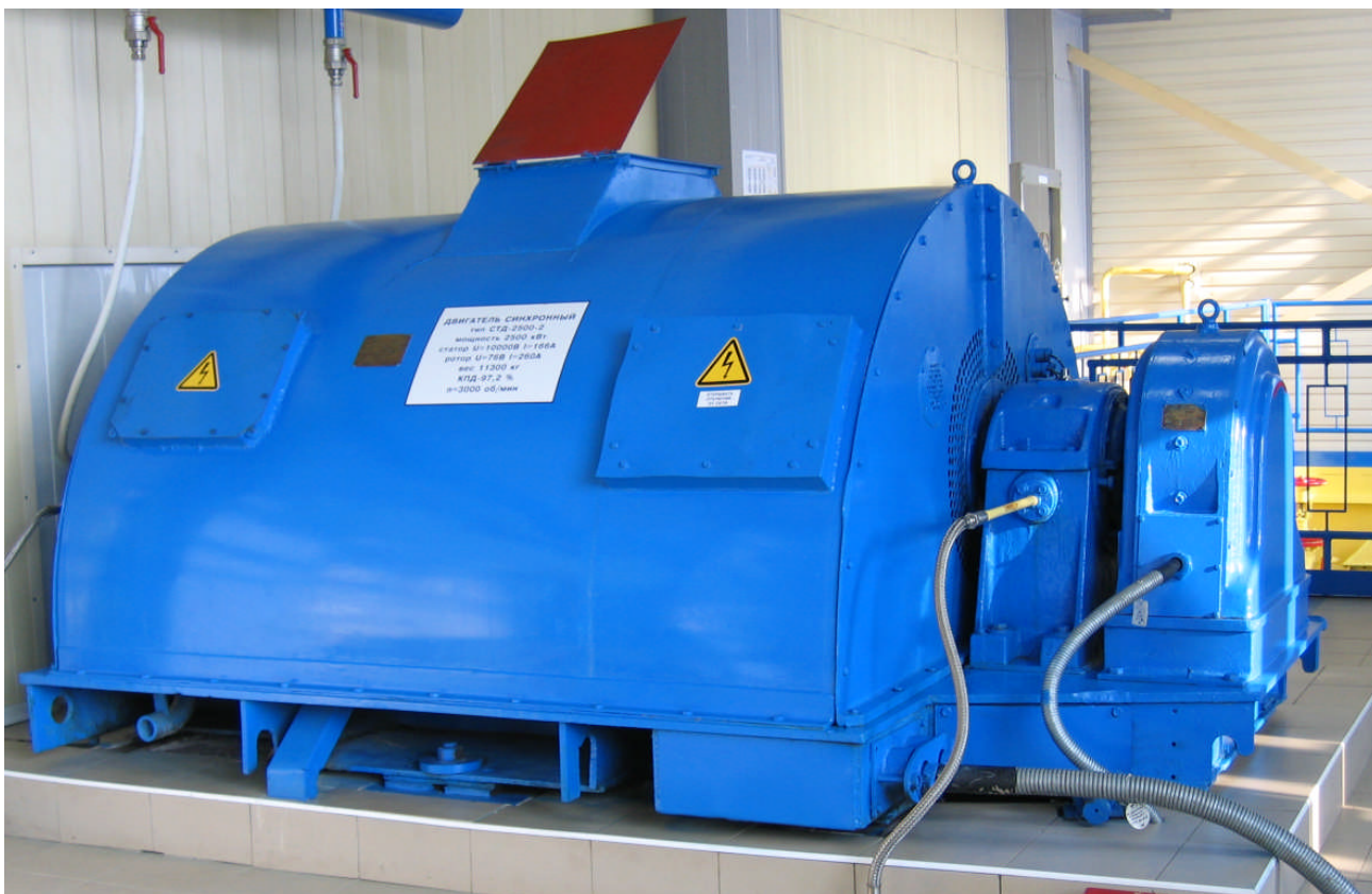
Рисунок 4.1 Синхронный электродвигатель с БВУ (безщёточным возбудительным устройством)
