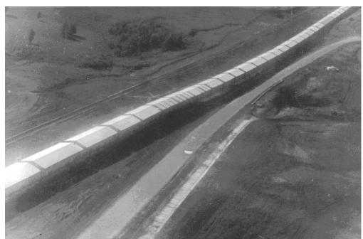
Березовская ГРЭС знаменита нетрадиционной схемой поставки топлива. Бурый уголь поступает на станцию непосредственно с Березовского месторождения Канско-Ачинского бассейна с разреза «Березовский-1» двумя 14-километровыми открытыми конвейерами. Проектная производительность разреза - 55 млн тонн угля в год. Всего за один час на ГРЭС может поступать до 4,5 тыс. тонн угля. За год на золоотвал станции поступает 250 - 300 тыс. тонн сухой золы. Удаление золы осуществляется
