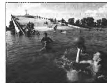
Мост, разбомбленный военно-воздушными силами НАТО в 1999 г. в ходе «гуманитарной интервенции», вызванной антитеррористической операцией Югославии на собственной территории — в крае Косово.
